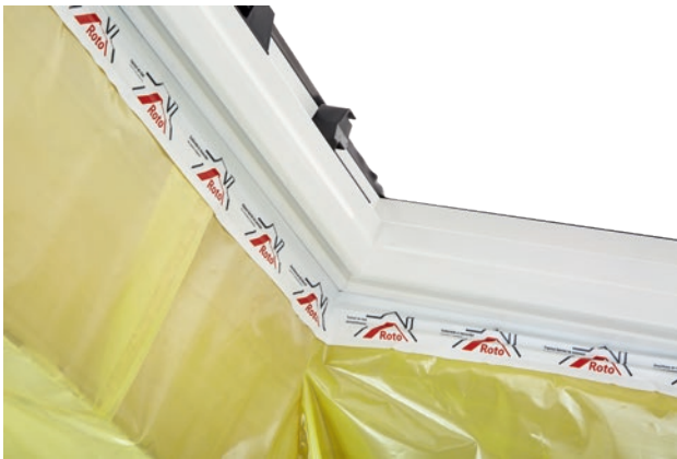
Die Anschlusschürze innen montiert
